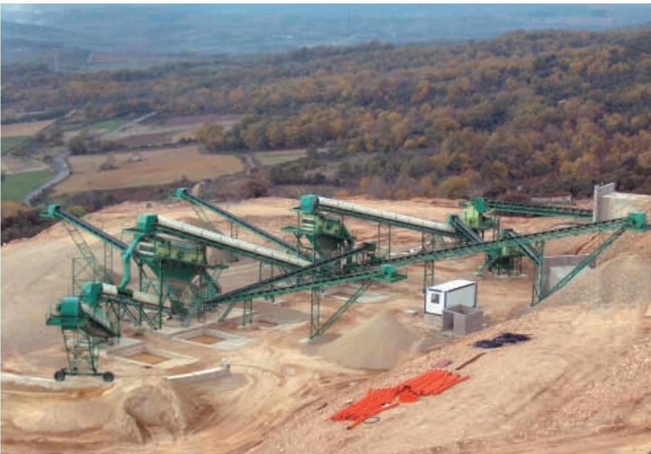
Figura 1.- Vista parcial de la planta de Graveras del Bierzo.
