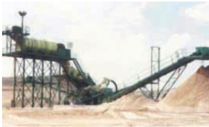
Figura 4.- La etapa de lavado cuenta con un trómel, cribado en vía húmeda y un lavador de arenas.
