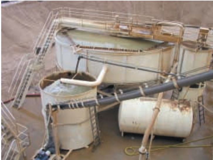
Figura 11.- Equipo decantador de lodos Triman para el tratamiento de las aguas en la planta de Aricemex en Toledo.
