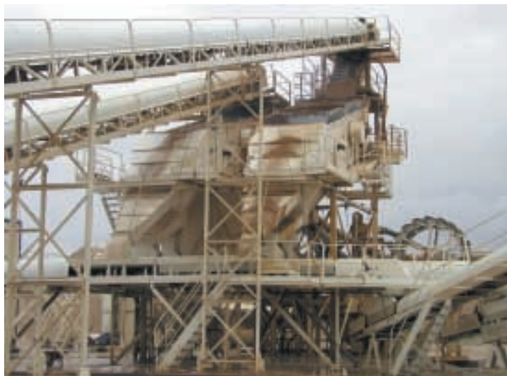
Figura 6.- Etapas de clasificación con cribas Triman CVT-2270-III para la fabricación de gravillas.
