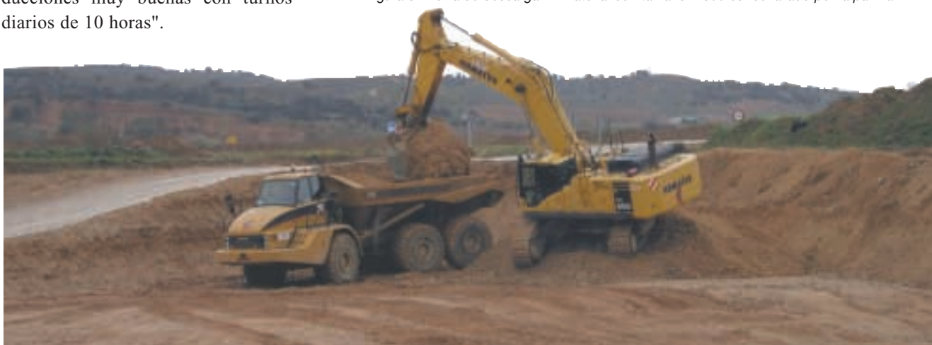
Figura 2.- Frente de extracción de la cantera de Aricemex.
